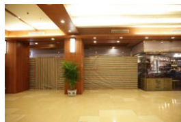
△ 世茂工三商场里正在进行的装修
